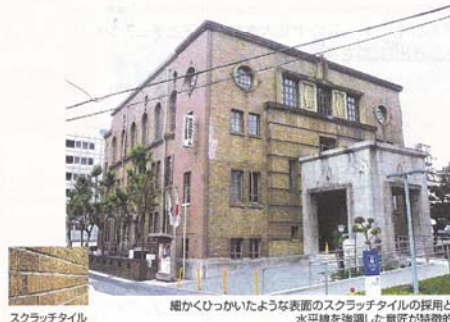
スクラッチタイル 縞かくらついたような表面のスクラッチタイルの採用と水平線を強調した意匠が特徴的
