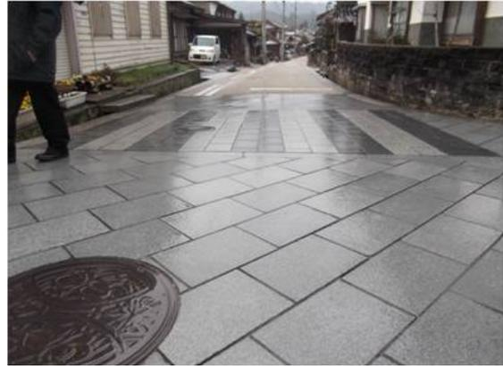
交差点部は鹿野祭りの屋台が方向転換した際に舗装を痛めないよう石張舗装となっている
