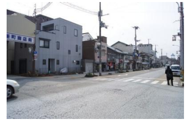
アーケード撤去された 「広小路商店街」 (広小路リニューアル事業)
