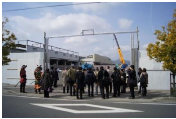
「(仮称) 市民交流プラザふくちやま」 建設風景 (福知山駅周辺賑わい創出事業)
