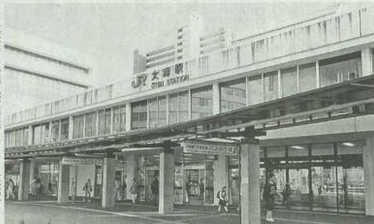
外壁などの老朽化が進んでいるJR大津駅
