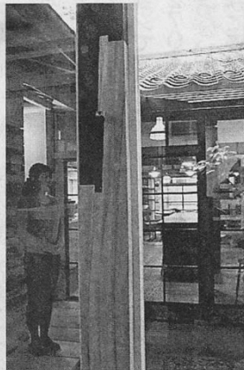
柱の朽ちた部分に新たな木材を継いで再生した大津の空き町家の再生は大工の技術継承の場にもなっている(大津市御幸町・大津百町スタジオ)
