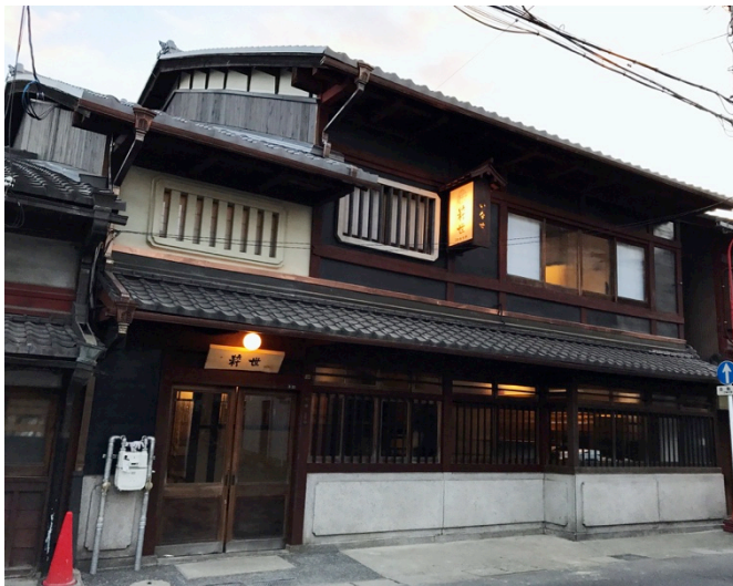
△「大津町家の宿 粹世」外観
