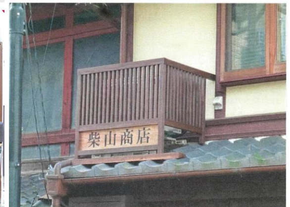
屋外広告物を兼ねた室外機覆
